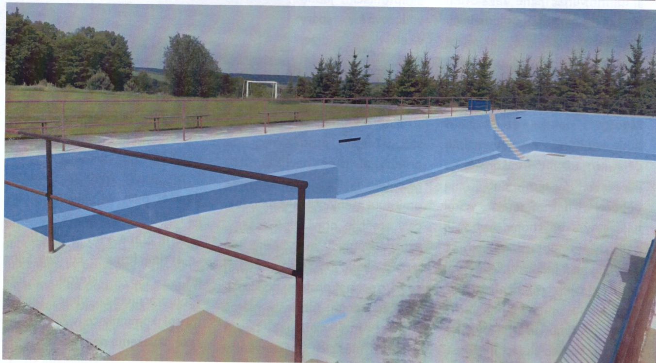
Areál v Zálesí v novém kabátě
